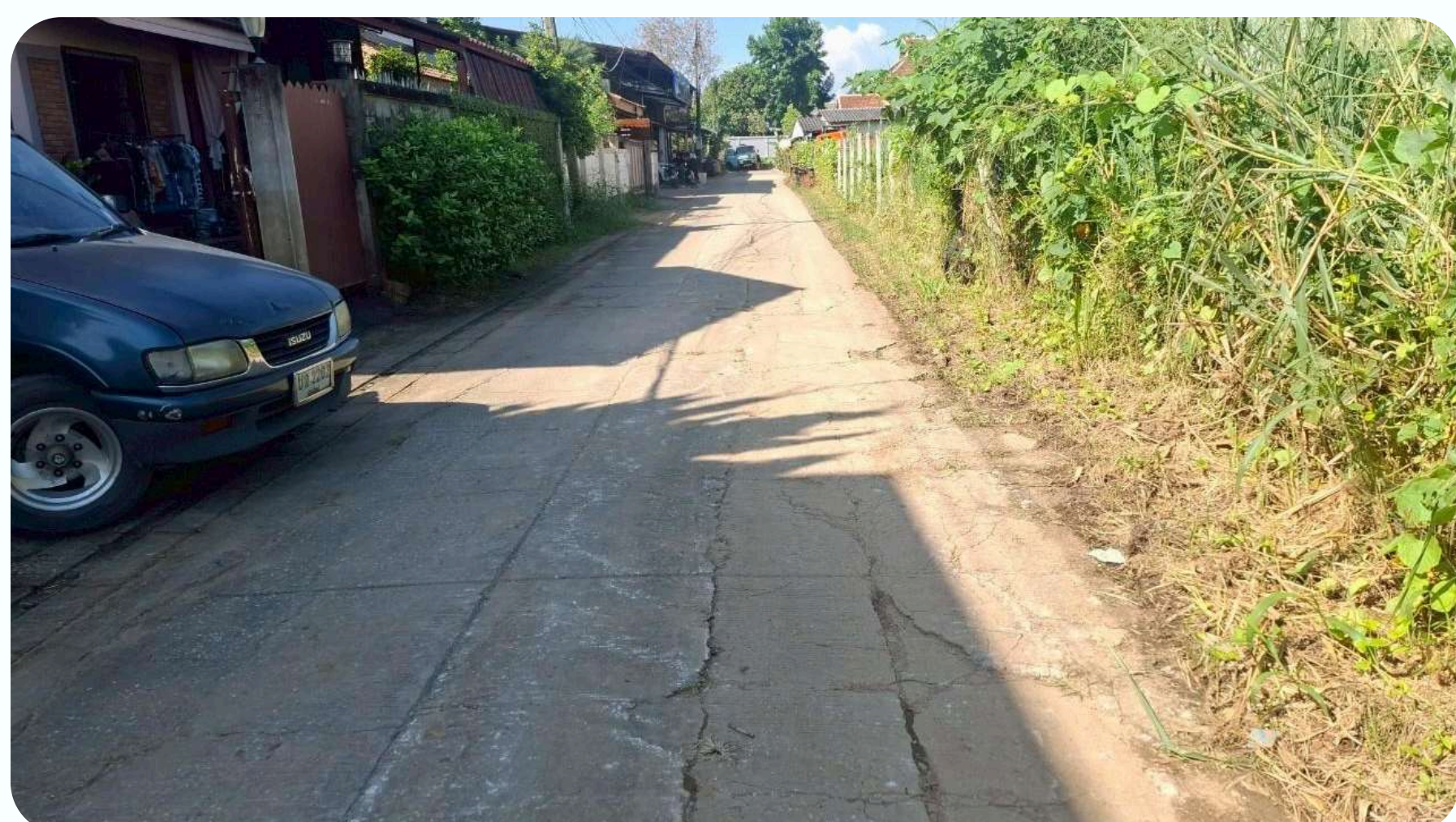
โครงการปรับปรุงถนนแอสฟัลต์ติกคอนกรีต รหัสสายทาง ชม.ถ.91-070 สายทางสันป่าเลียง ซอย 2 หมู่ที่ 4 บ้านสันป่าเลียง ตำบลหนองหอย
