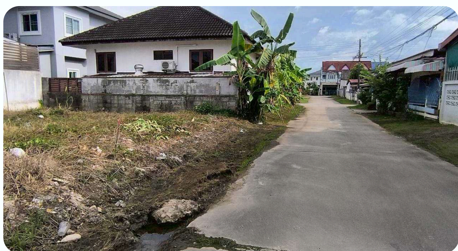
โครงการก่อสร้างรางระบายน้ำคอนกรีตเสริมเหล็กรูปตัวยูแบบมีฝาปิด ซอย 8 เชื่อมซอย 12 หมู่ที่ 7 บ้านชัยพฤกษ์ ตำบลหนองหอย
